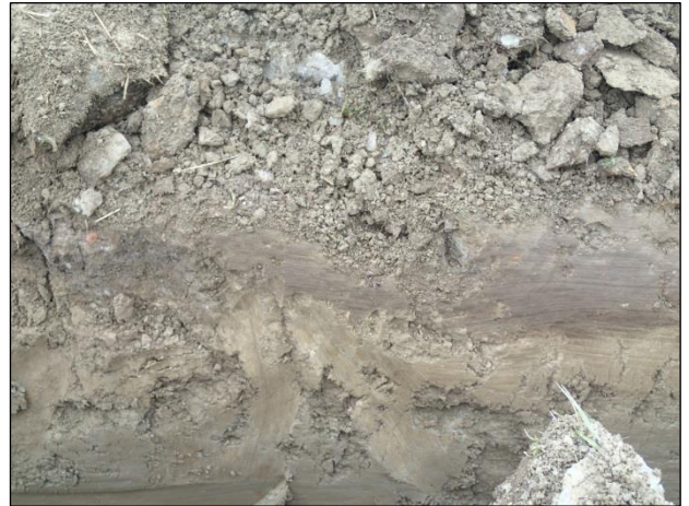
Oikealla: Kaivanto maadoituskaapelille uuden muuntajan paikalla Itko 3 muinaisjäännösalueen keskiosan pohjoisreunassa. Kaivannossa normaalit kerrokset, ylinnä peltomulta, sen alla savi. Kuva lounaaseen. Vasemmalla: Maakerroksia maakaapelikaivannon seinämässä Itko 3 muinaisjäännösalueen itäosan pohjoispuolella. Kaivannossa normaalit maakerrokset, ylinnä muokkauskerros, sen alla sen alla savi.
