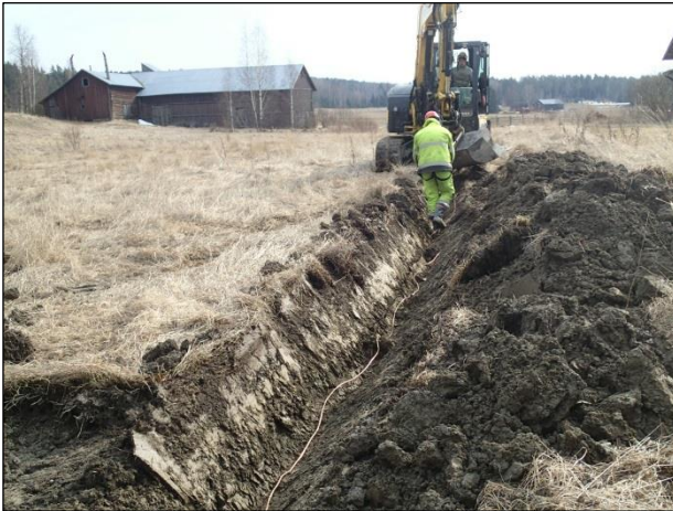
Oikealla: Kaivanto maadoituskaapelille uuden muuntajan paikalla Itko 3 muinaisjäännösalueen keskiosan pohjoisreunassa. Kaivannossa normaalit kerrokset, ylinnä peltomulta, sen alla savi. Kuva lounaaseen. Vasemmalla: Maakerroksia maakaapelikaivannon seinämässä Itko 3 muinaisjäännösalueen itäosan pohjoispuolella. Kaivannossa normaalit maakerrokset, ylinnä muokkauskerros, sen alla sen alla savi.
