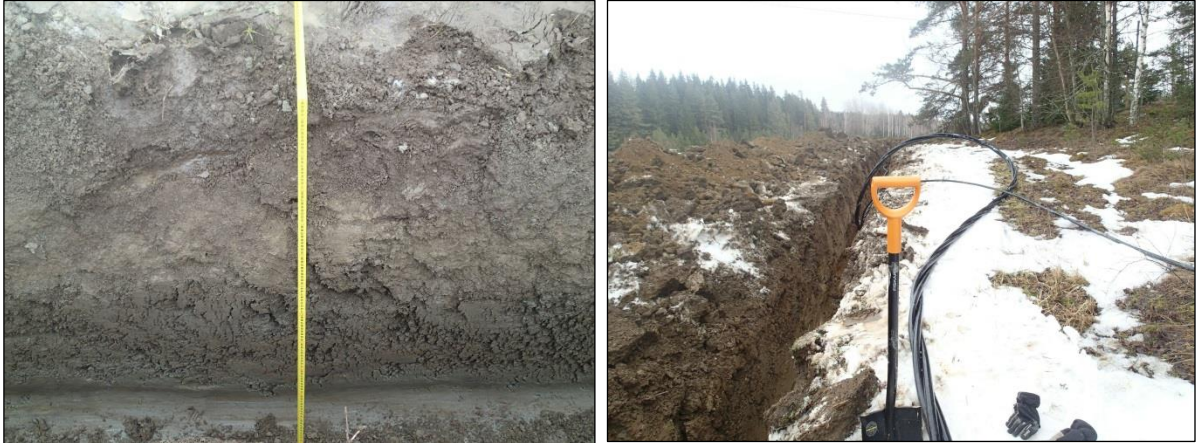
Kaivannoissa normaalit peltomaan maakerrokset. Maakaapelikaivantoa moreenikumpareen pohjoispuolella.
